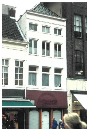
Brugstraat 3, voorgevel voor de restauratie van 2003
