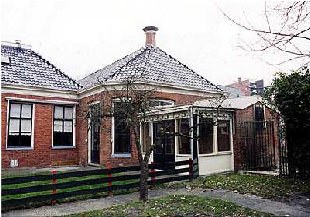
Afb. 9. Het achterste gedeelte van bouwdeel B met de tuinkamer. Foto: Taco Tel.
