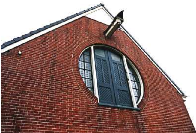
Afb. 15. Het grote rondvenster in de oostgevel van bouwdeel C. Foto: Rita Overbeek.
