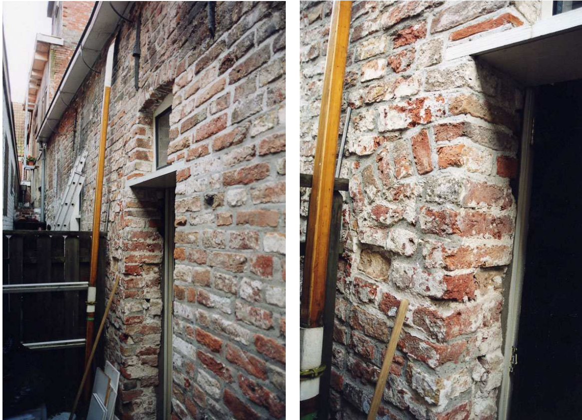
De achtergevels van Haddingestraat 36 en naastgelegen panden (linker foto) en een bouwspoor van een ontlastingsboog van een vroegere deur.
