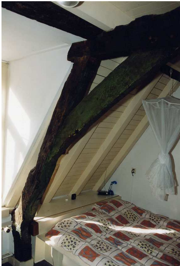
Foto boven: de balklaag boven de begane grond. Links een 15 e eeuwse eikenhouten gebint.
