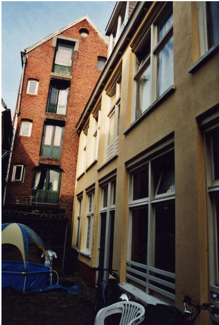
De gepleisterde gevel rechts is de voorgevel van het achterhuis.
