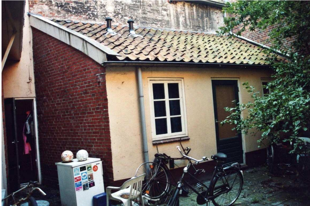
De achtergevel met aanbouw onder een lessenaarsdak.
