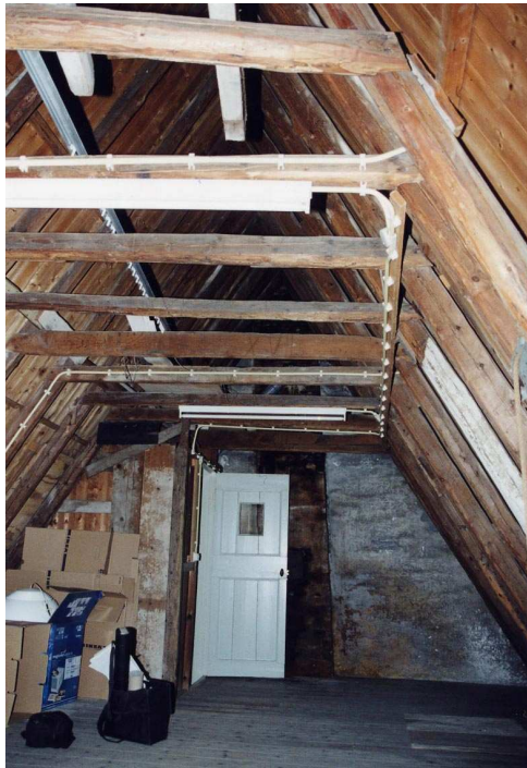
De kapconstructie naar achteren gezien.
