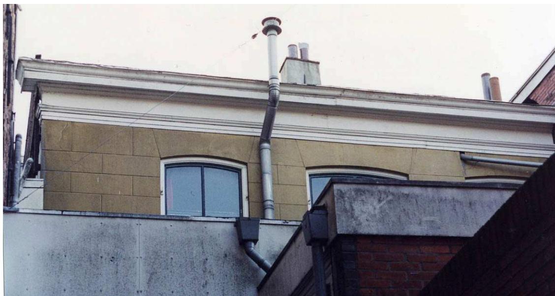
De achtergevel van het achterhuis.
