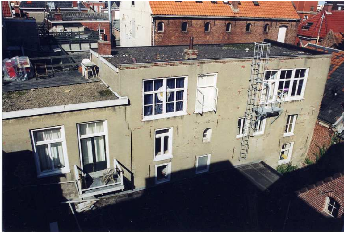
De zuidgevel van de achterhuizen.
