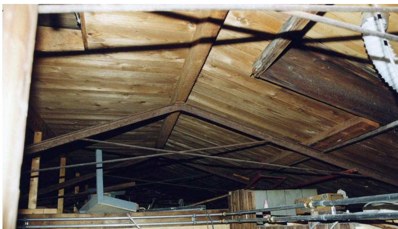
De kapconstructie met stalen spanten
