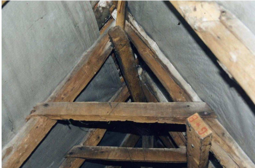
Het voorste deel van de zolder met een 17 e eeuwse kapgebint.
