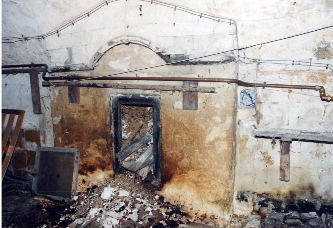
De 18 de -eeuwse schouw tegen de rechter zijgevel in de voorruimte.
