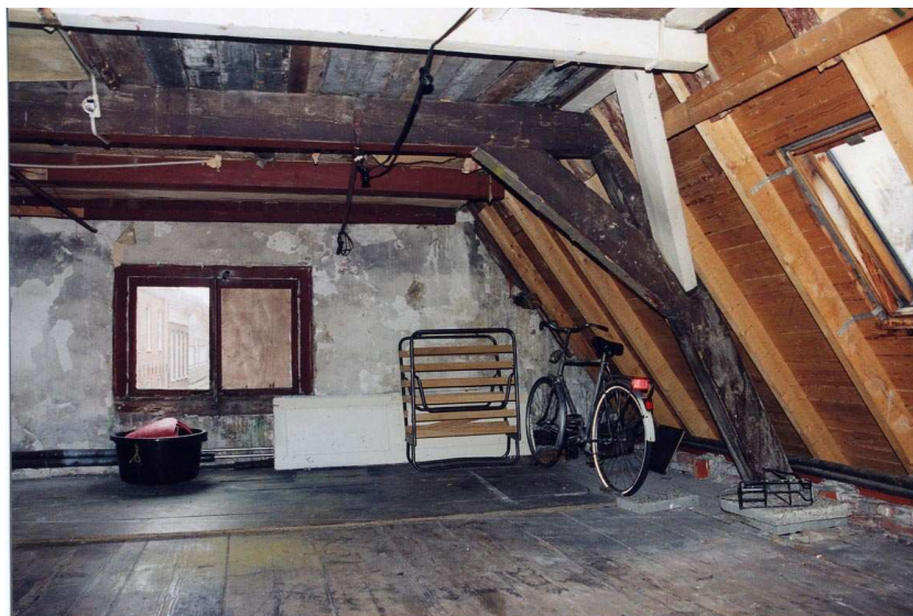
Deel van de 17 e eeuwse sporenkap met gezaagde talmenken
