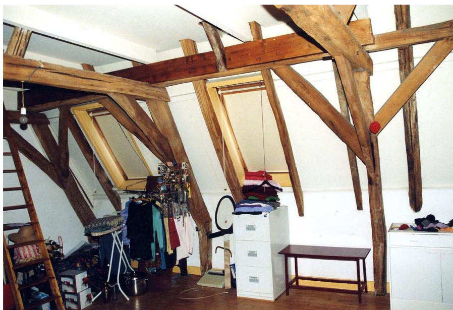
De eikenhouten kapconstructie van het voorhuis.
