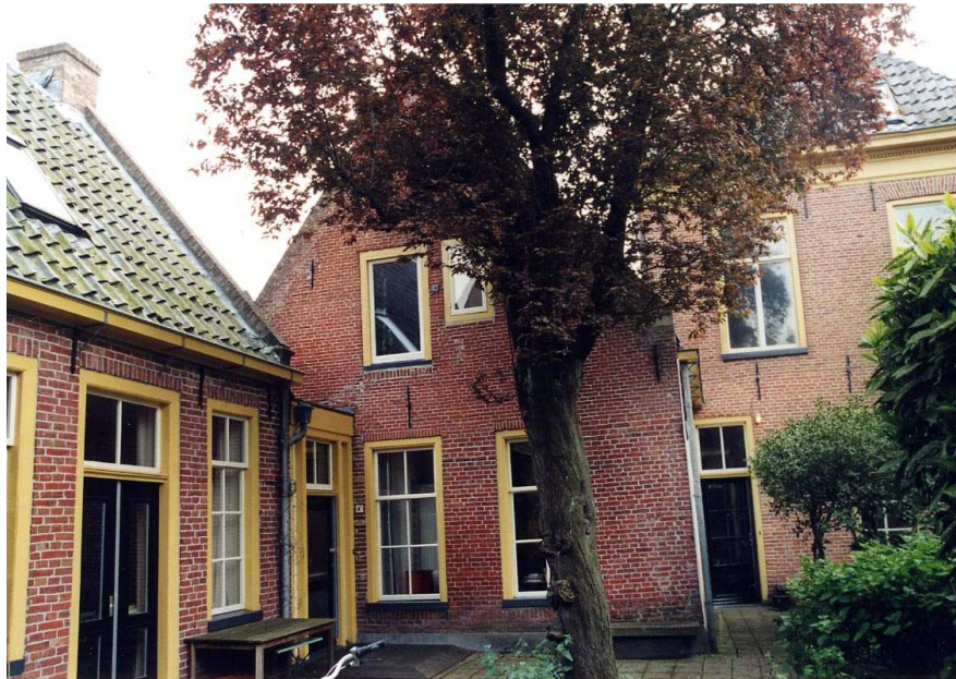
De achterkant van het complex aan de Pausgang; links bouwdeel IV, achter de boom bouwdeel III en rechts
