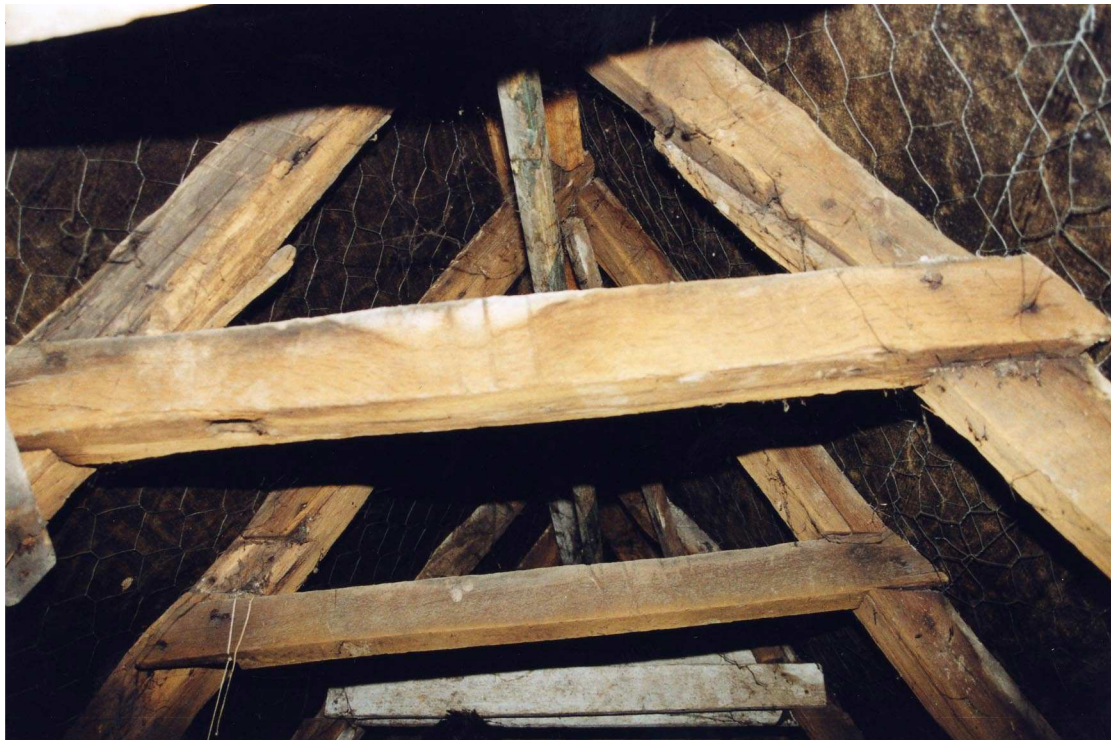
Foto van de eikenhouten sporenkap met gezaagde merken.
