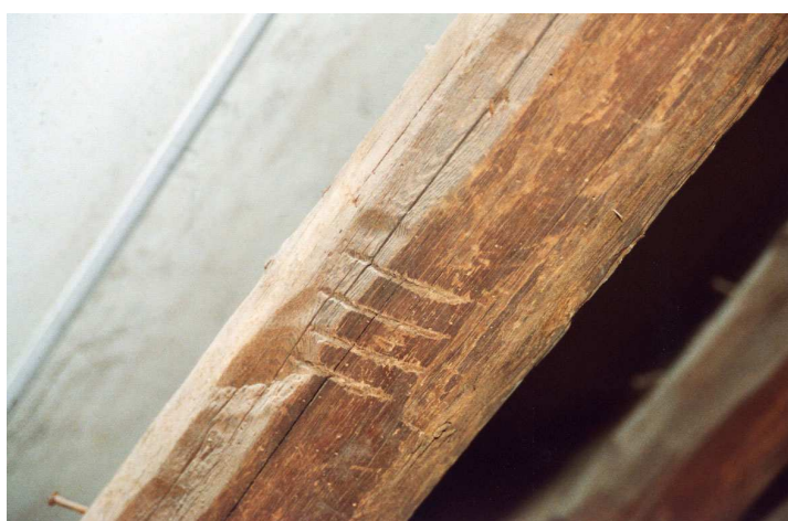
Detail van de kapconstructie met een gezaagd telmerk.
