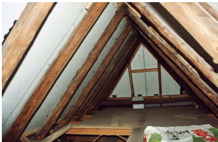
Overzicht van de kapconstructie ter hoogte van de vloering.
