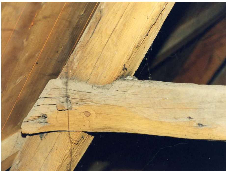
Detail van de eikehouten kap. De houtverbinding van een haanhout met een dakspoor.
