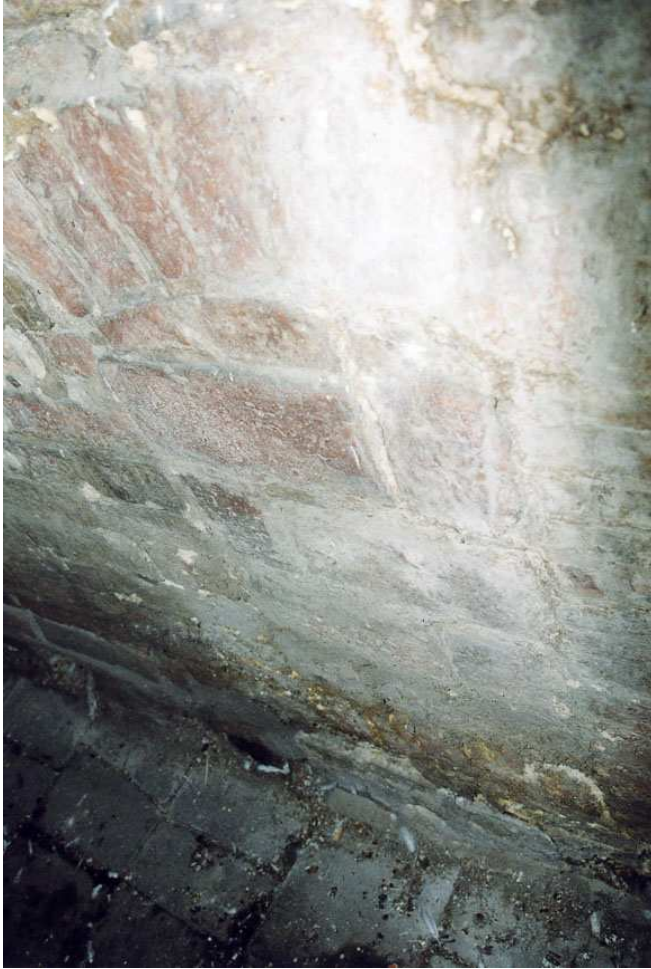
Een van de dichtgemetselde keldervensters.
