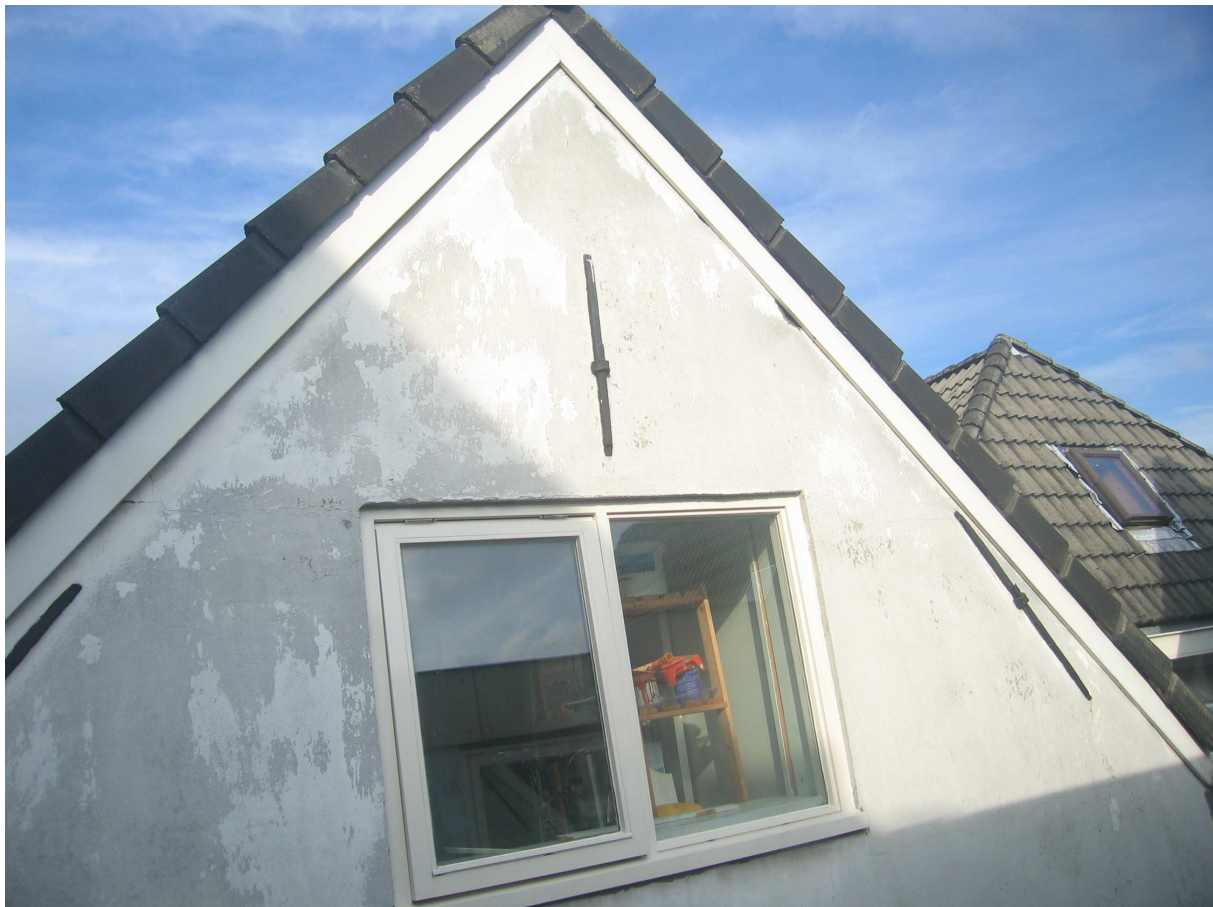
De top van de achtergevel van het voorhuis.
