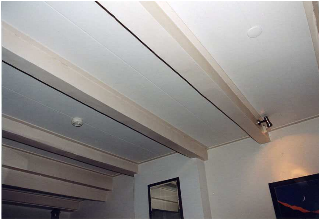
De balklaag boven de voorkamer op de verdieping.
