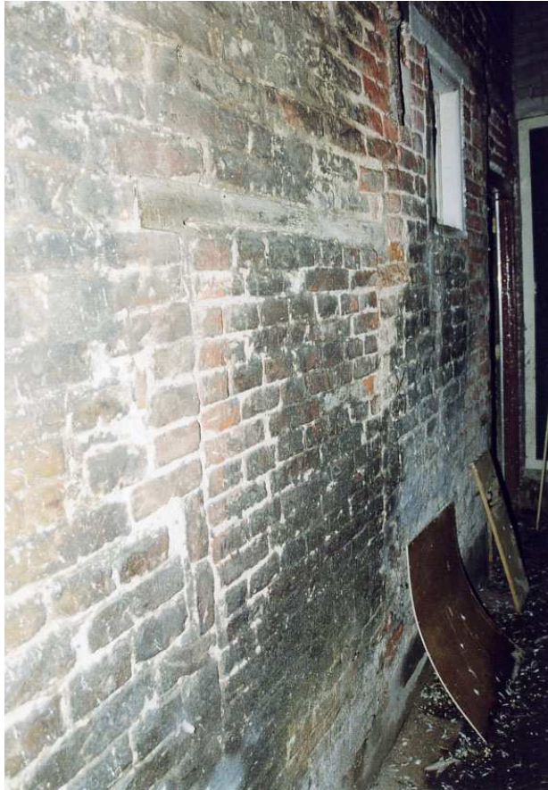
Dichtgezette deuropening met eikenhouten latei met deursponning.
